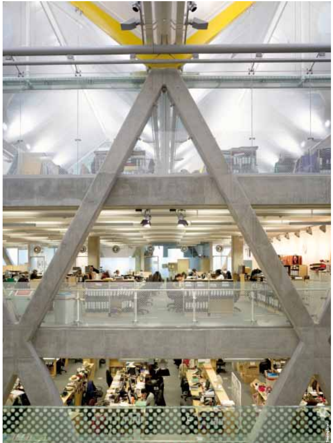
Il sottotetto è caratterizzato dalla copertura a shed lasciata a vista in cui spiccano le travi di sostegno di colore giallo acceso The space under the roof is characterised by the fair faced shed in which the bright yellow supporting beams stand out
