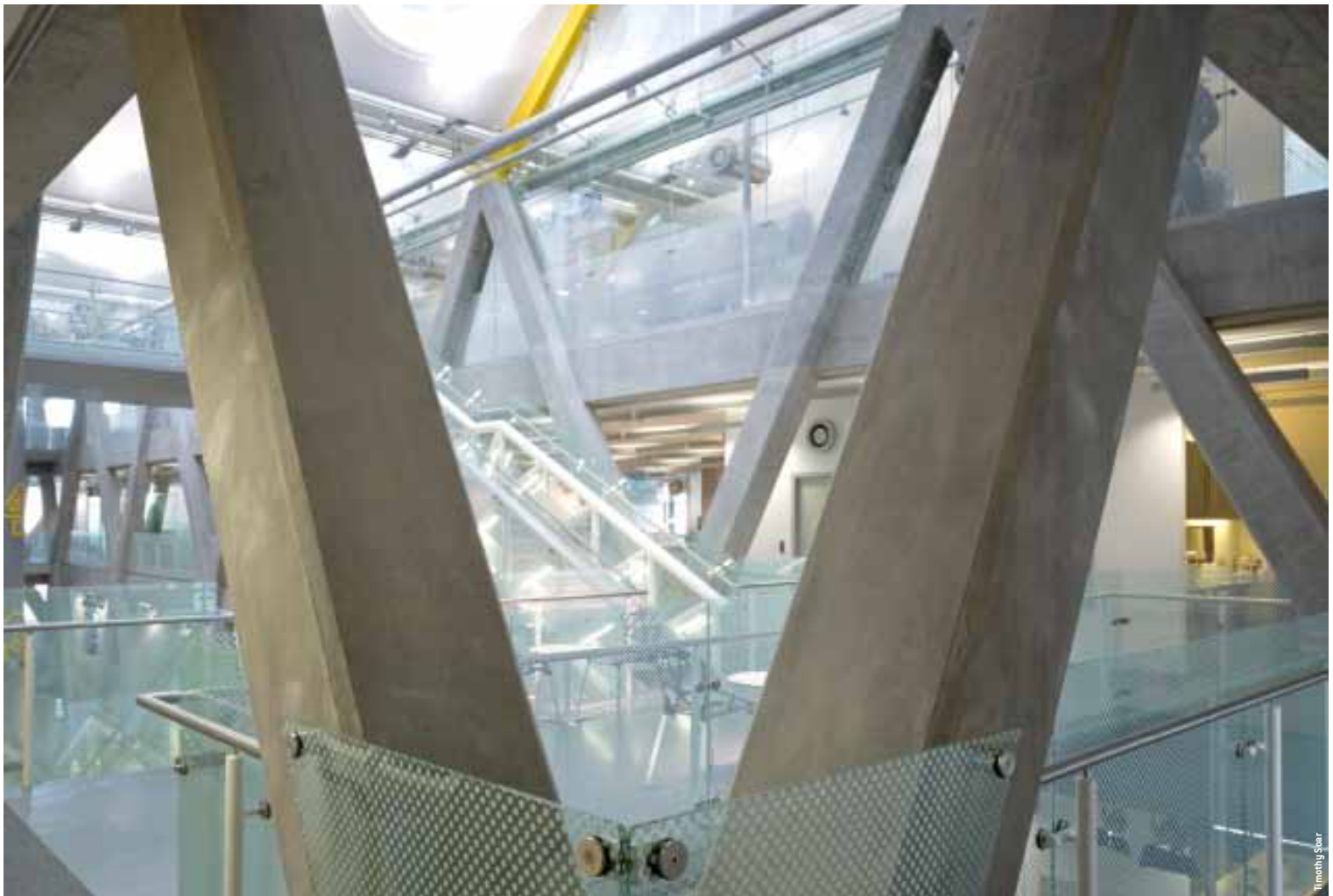
L'atrio centrale a tutt'altezza ospita anche i collegamenti verticali The full height central atrium also houses the vertical connections
