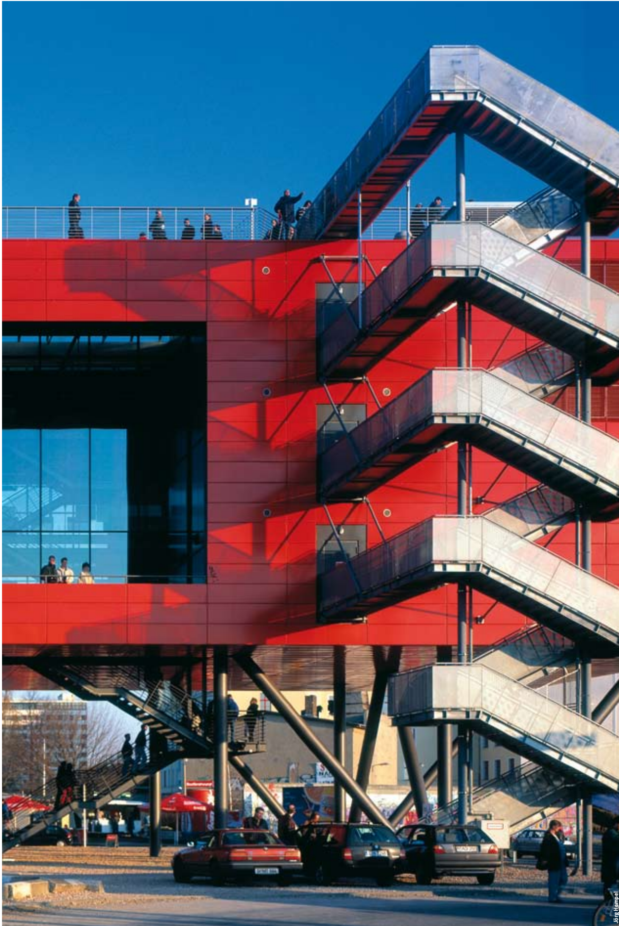
Le scale metalliche dell'uscita di emergenza Emergency exit's metal staircases
