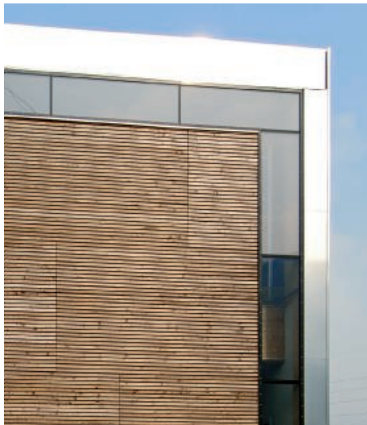
Finestre a nastro di collegamento tra rivestimento di legno della facciata est e finitura di alluminio della porzione nord
