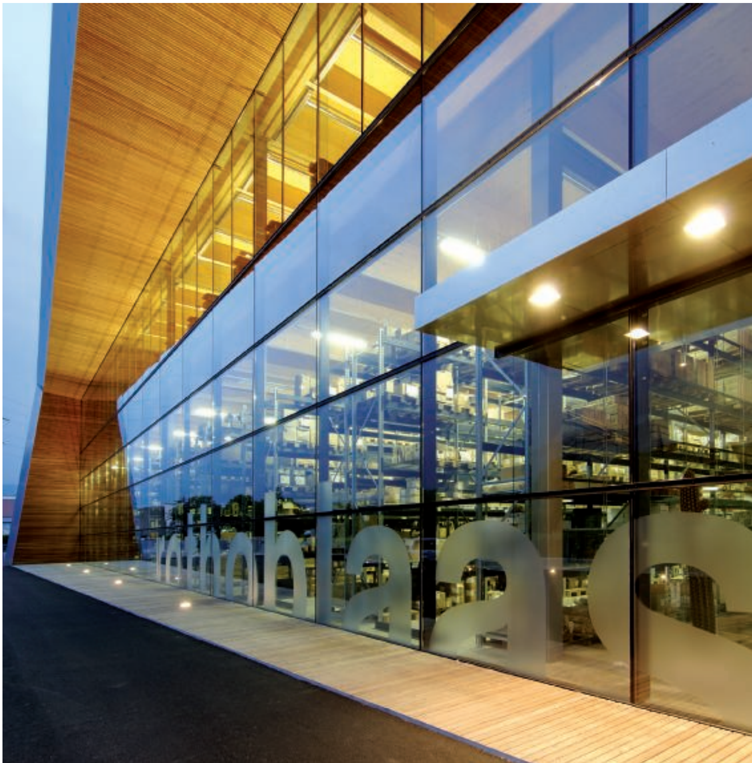
Vista della facciata sud con la profonda sporgenza della copertura in evidenza
