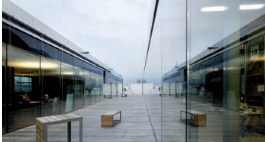
Vista della terrazza al primo piano
