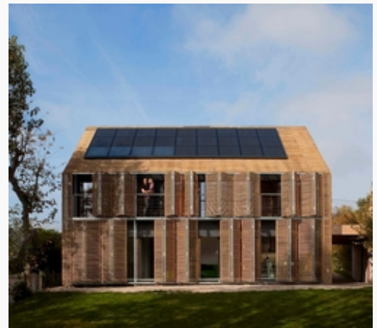
esempio di casa passiva ( www.rifaidate.it )
