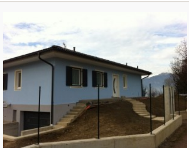
fase conclusiva di costruzione di un edificio a telaio – www.elenaformenti.it
