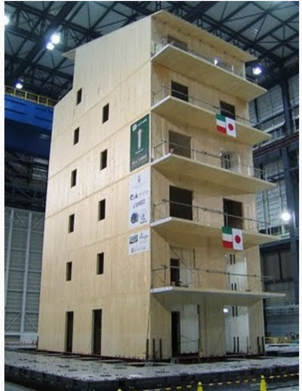
progetto Sofie: edificio multipiano costruito in laboratorio per eseguire un test sismico realizzata dal CNR IVALLSA di San Michele all'Adige (TN) su piattaforma a Miki in Giappone nel 2007
